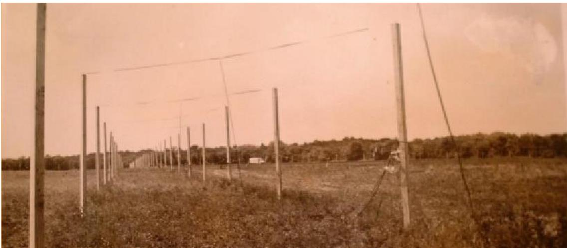
*Un brazo del Radiotelescopio Mills Cross, usado por Bruke y Franklin; un conjunto de antenas de 96 acres con 5 millas de cable en Seneca, Maryland, junto River Road.*
